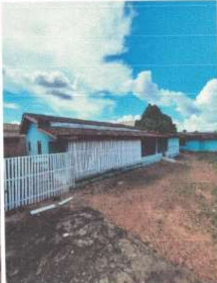
Imagem 2 – Fachada Lateral Direita
