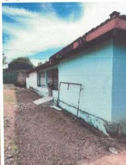
Imagem 3 - Fachada Lateral Direita
